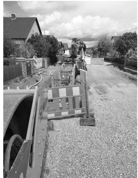
Zudem bereiteten auch die Bodenverhältnisse große Schwierigkeiten. Aufgrund des vorhandenen, schluffigen Lehms wurde ein Grabenverbau als Sicherung nötig. Im weiteren Verlauf werden die Kanal-Hausanschlüsse in diesem Bereich nachgeholt, sobald der Hauptkanal in der südlichen Gartenstraße, auf Höhe Weidenweg, in ca. 2 Wochen verlegt ist.
